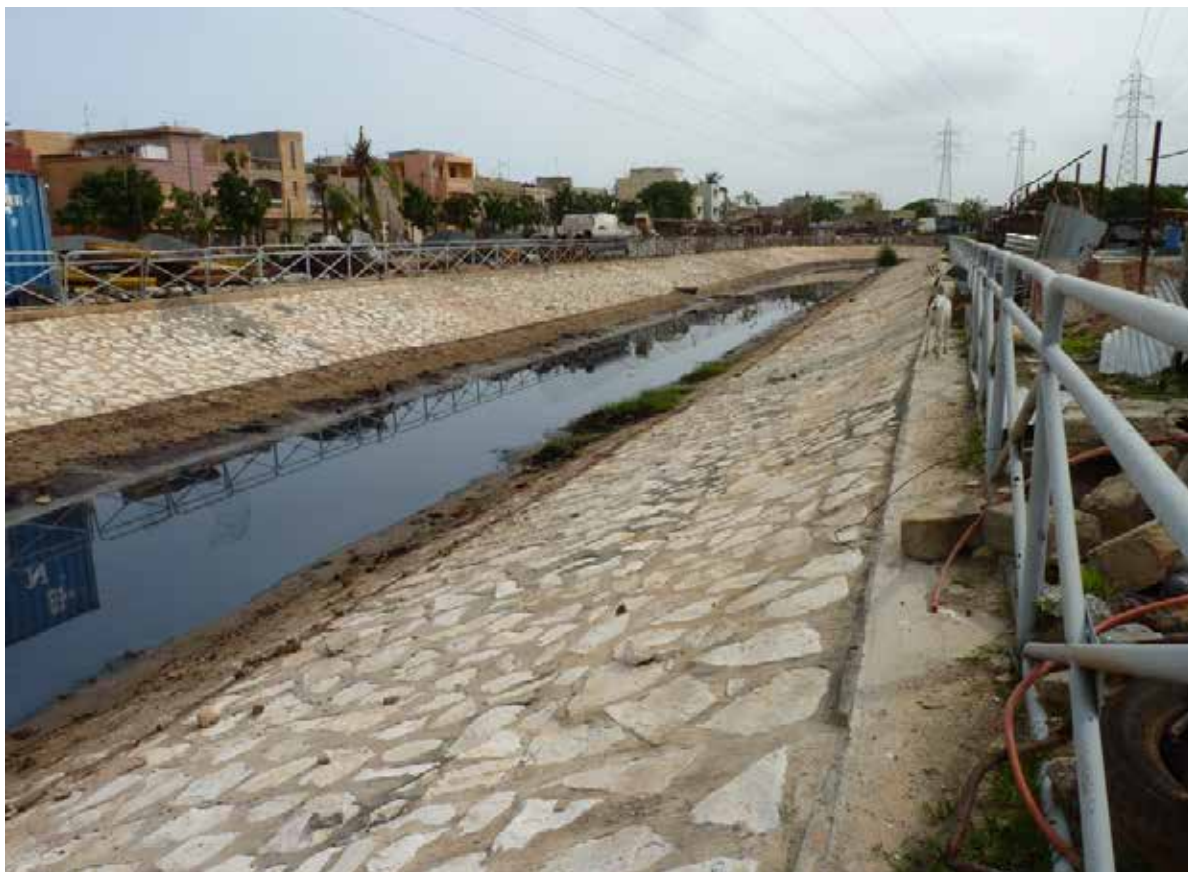
Un canal de drainage, à Dalifort-Foirail, permettant l'écoulement des eaux pluviales vers la mer.
